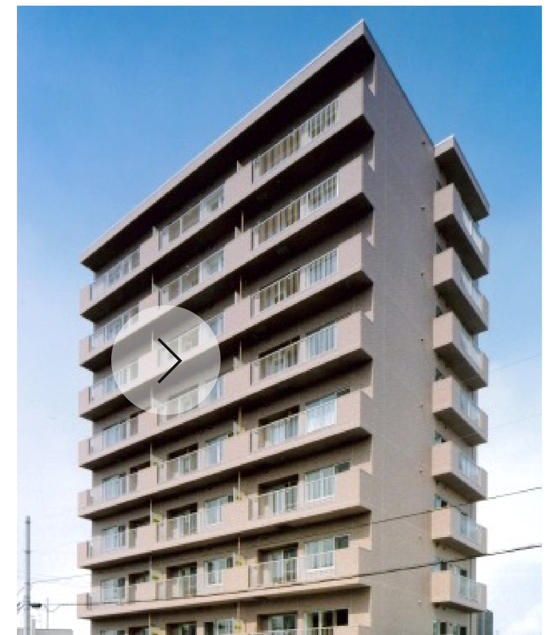
ビル・マンション改修工事
